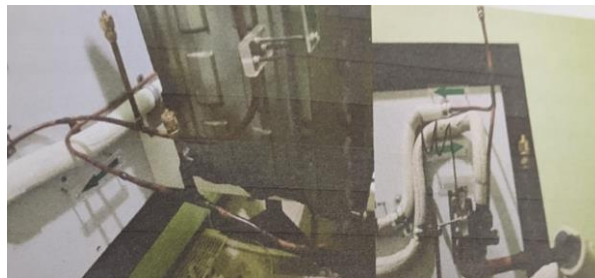
Gambar 3. 25 Penambahan Nipel Pengujian Tekanan Refrigeran
